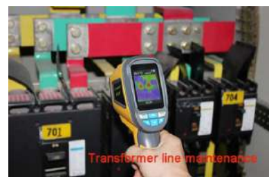
Manutenzione della linea del trasformatore Transformer line maintenance Mantenimiento de la línea del transformador
